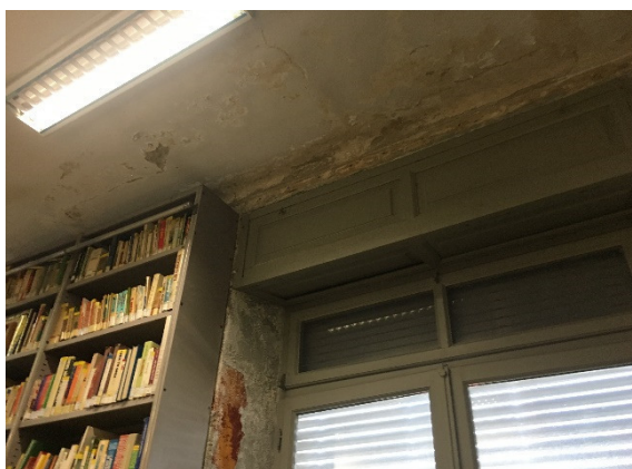
Immagine 8 – Piano primo – infiltrazioni da copertura
