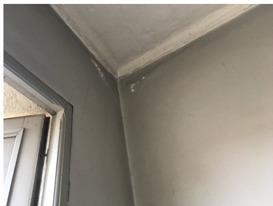
Immagine 7 – Vano scala – infiltrazioni da copertura
