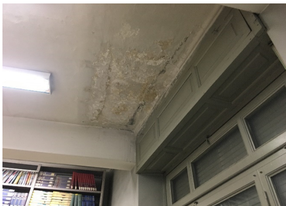
Immagine 5 – Piano primo - infiltrazioni da copertura
