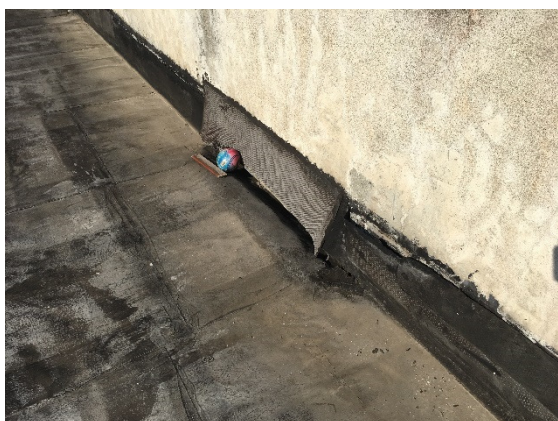
Immagine 3 – Distacco della guaina esistente
