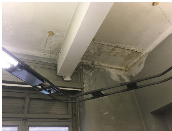
Immagine 6 – Piano primo - infiltrazioni da copertura
