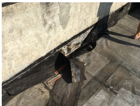
Immagine 4 – Distacco della guaina esistente
